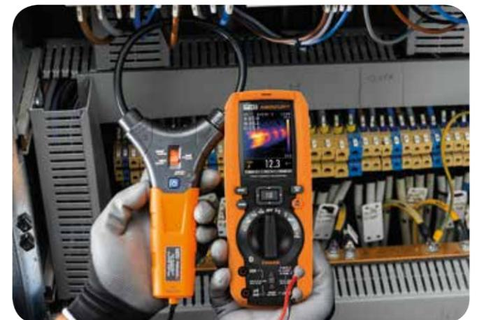
AC Strommessung mit flexiblem Wandler F3000U + Wärmebild.
