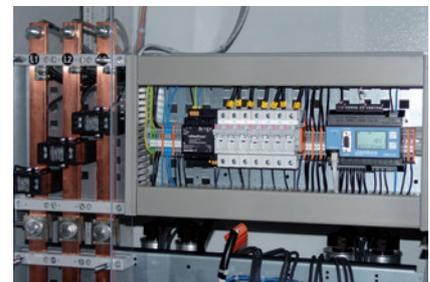
Abb.: Kondensatorüberwachung in einer Kompensationsanlage
